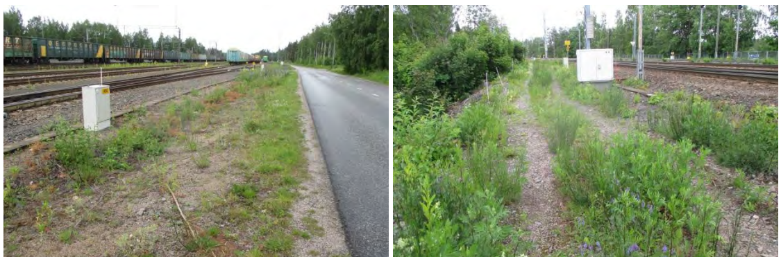
Kuvat 4 ja 5. Evakkotien reuna ja huoltotie ratapihan pohjoispuolella.
